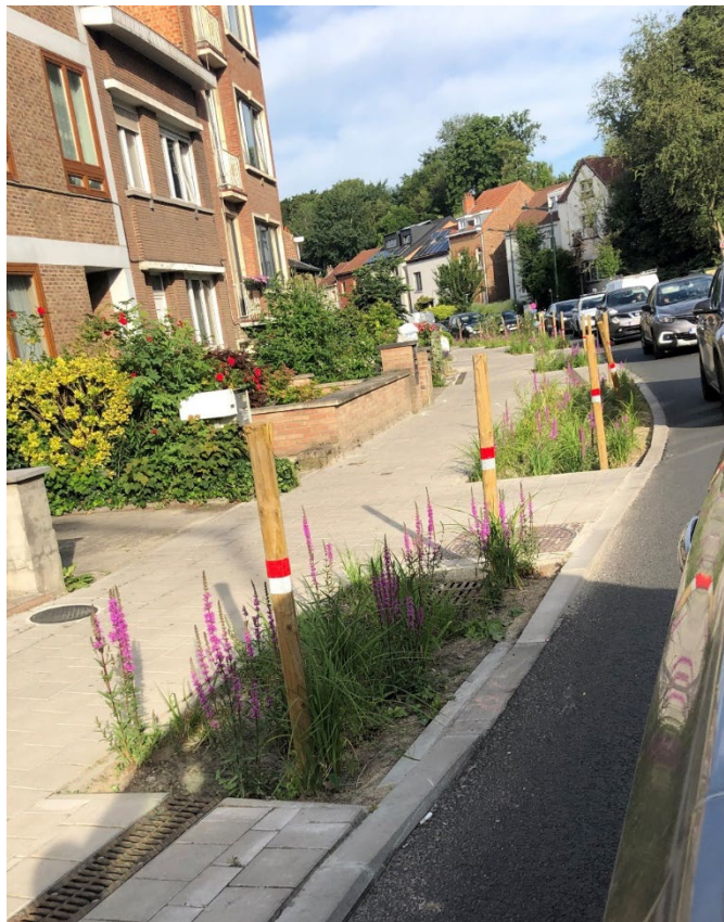
Figure 3- Gestion des eaux pluviales sur la parcelle et dans l'espace public - Bruxelles Environnement
